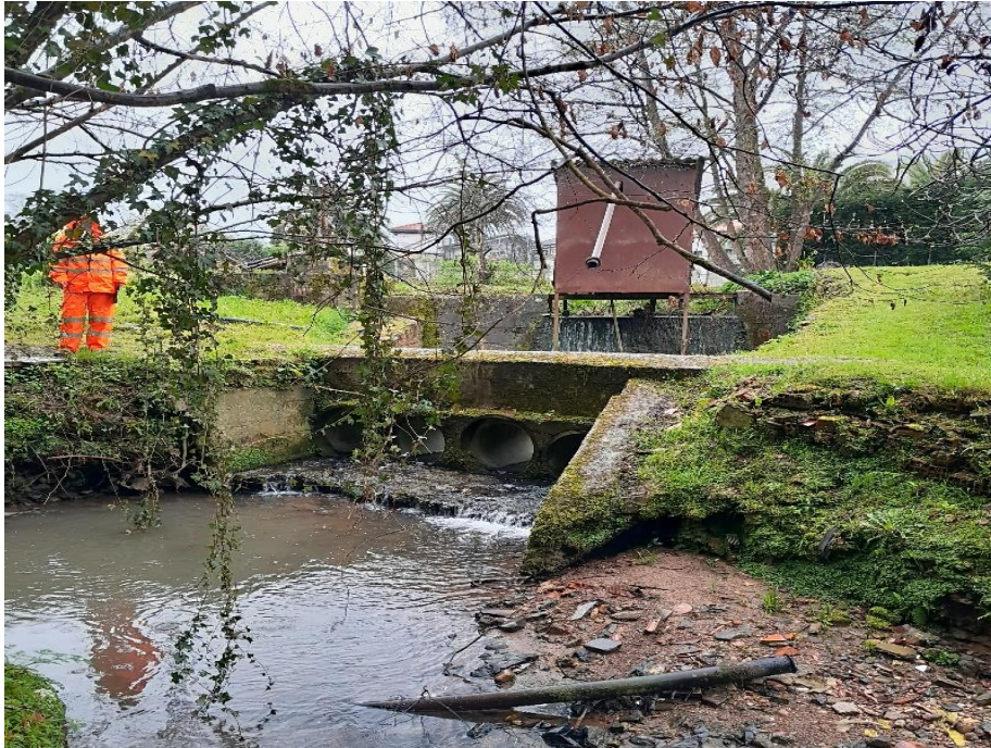
Foto 5. (960-8-16) Infraestructuras de captación de agua con azud y delante paso entubado sobre cauce en la confluencia del río Aboño con el arroyo Barranco de Terreno. coordenadas ETRS89, Huso 30 T, X: 271655, Y: 4816283.
