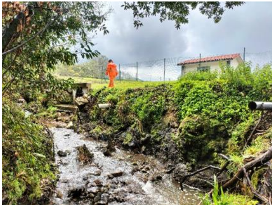
Foto 2. (960-8-06) Problemas de erosión por ausencia de vegetación en el río Aboño, a su paso por La Vega T.M. La Llanera, coordenadas ETRS 89, Huso 30T, X: 272618, Y: 4816306.
