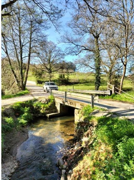
Foto 7. (960-7-14) Paso elevado sobre el río Aboño, con estribos en el cauce, coordenadas ETRS 89, Huso 30T, X: 274495, Y: 4817435.
