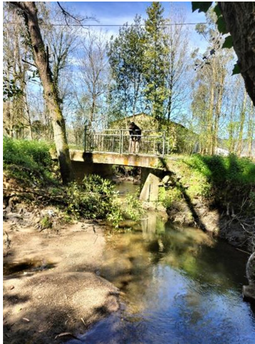
Foto 3. (960-7-08) Reducción de la sección natural del río Aboño, por la presencia de un paso elevado con sus estribos en el cauce, a su paso por la localidad de Naviella, coordenadas ETRS 89, Huso 30 T, X: 274617, Y: 4818945 .
